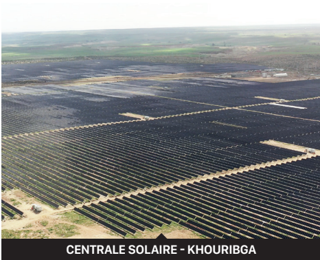
CENTRALE SOLAIRE - KHOURIBGA
